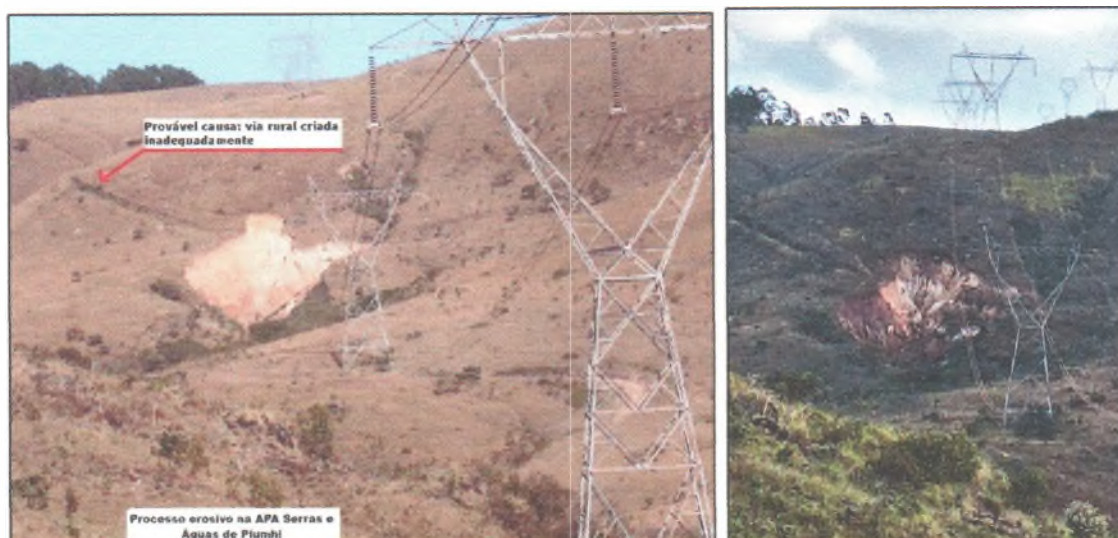
Figura 05 – Processo erosivo próximo à linha de transmissão de energia – 2006 e 2024.
