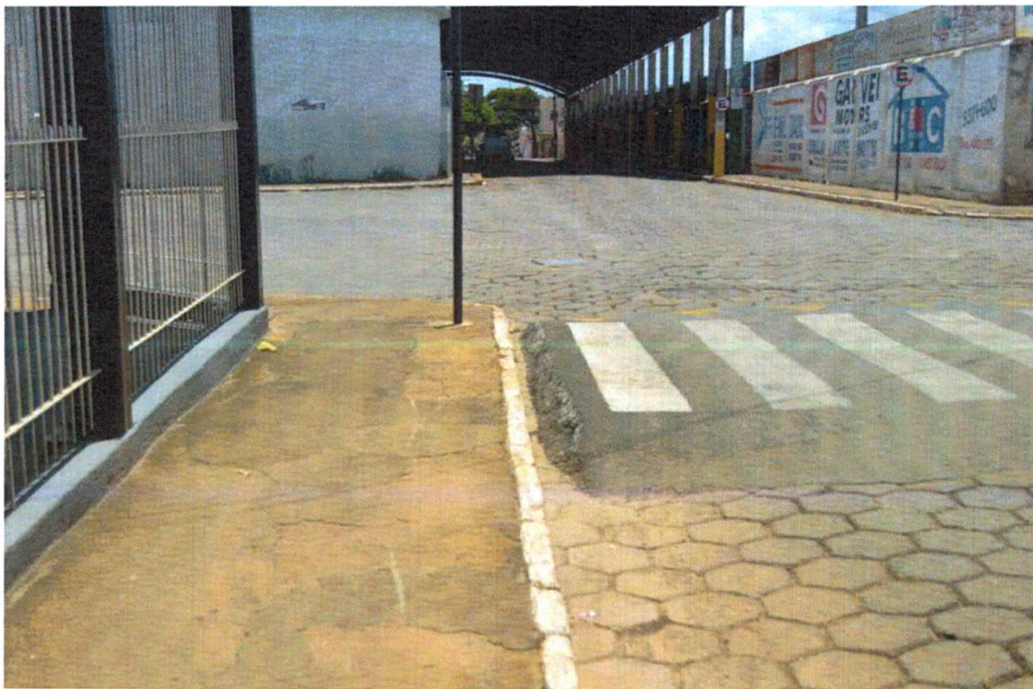
Rampa elevatória em desconformidade com a normas da ABNT (Rua Getúlio Vargas)
