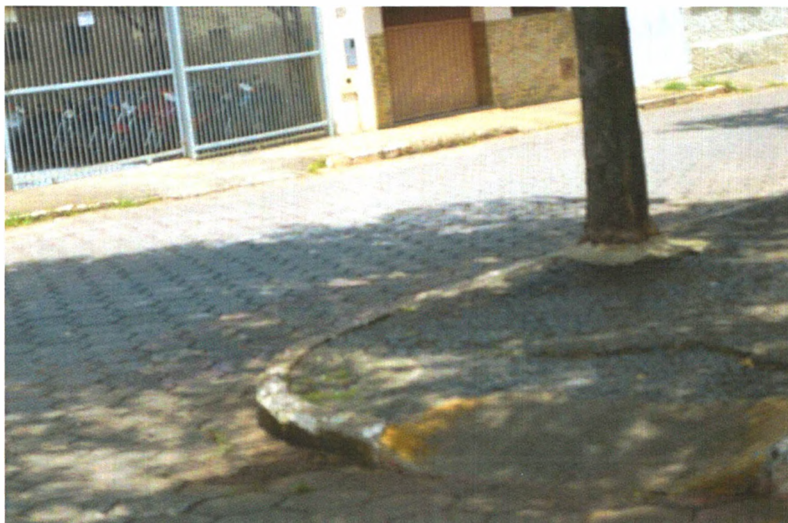
Rampa e placa comprometendo o transito de pedestres, rampa fora do padrão normas de acessibilidade (praça do Rosário)
