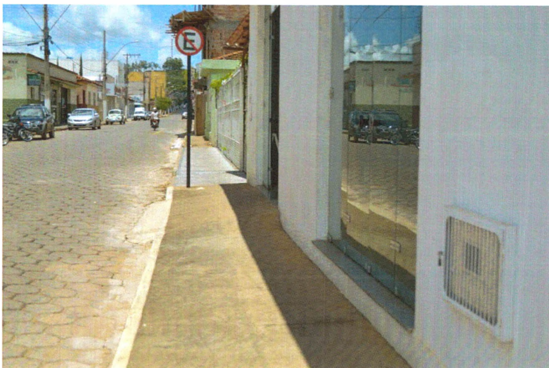
Rampa estabelecimento comercial comprometendo a calçada (Rua Getúlio Vargas)
