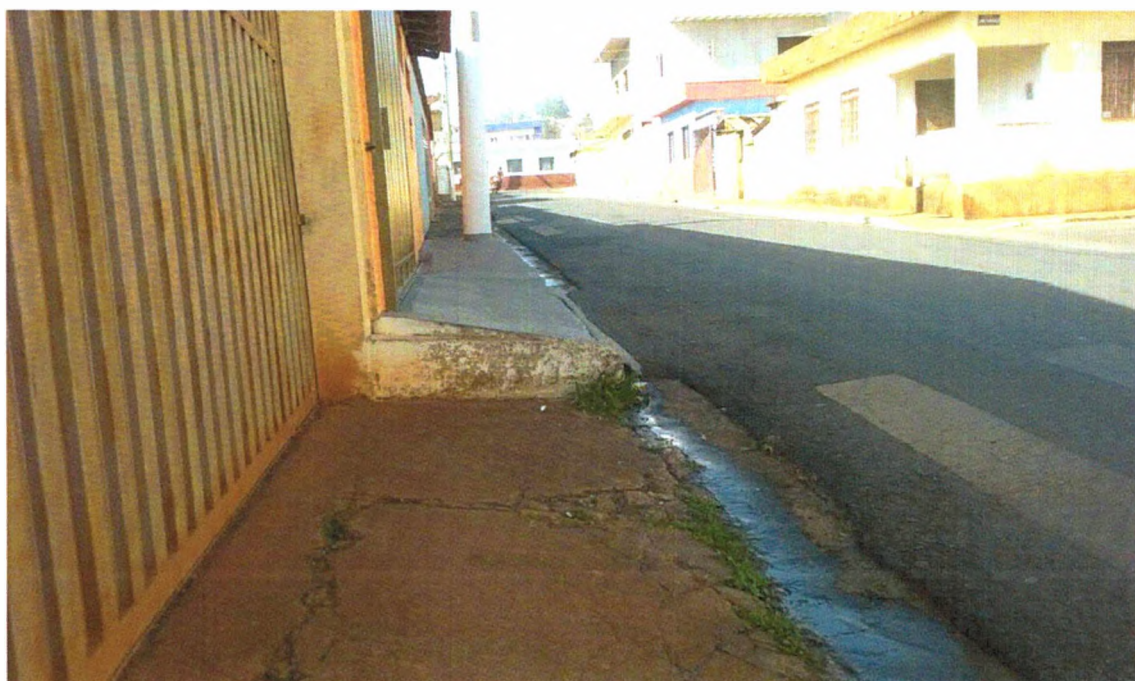
Rampa para acesso veículo garagem comprometendo a calçada
