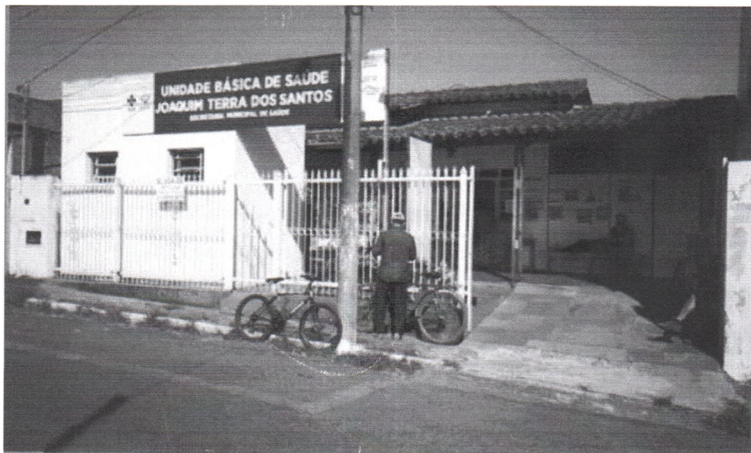
Fig.1 – Imóvel anteriormente alugado no qual funcionava a UBS
