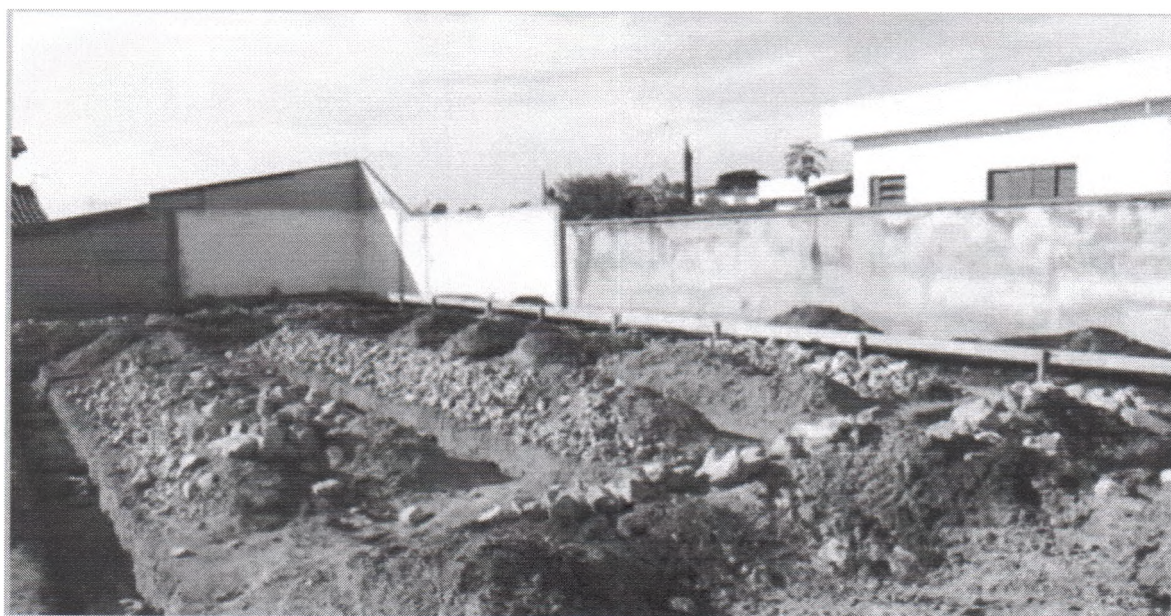
Figura 2 – Início das obras da sede própria
